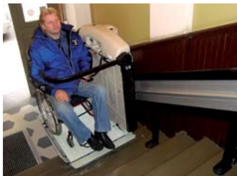
Elektriskais pacelājs iekļūšanai ēkā personām ar kustību traucējumiem Autors: Inese Vilcāne
